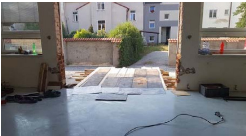
Stavební úpravy pro novou učebnu CNC
