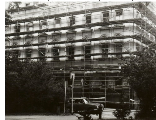
Budova školy pod lešením
