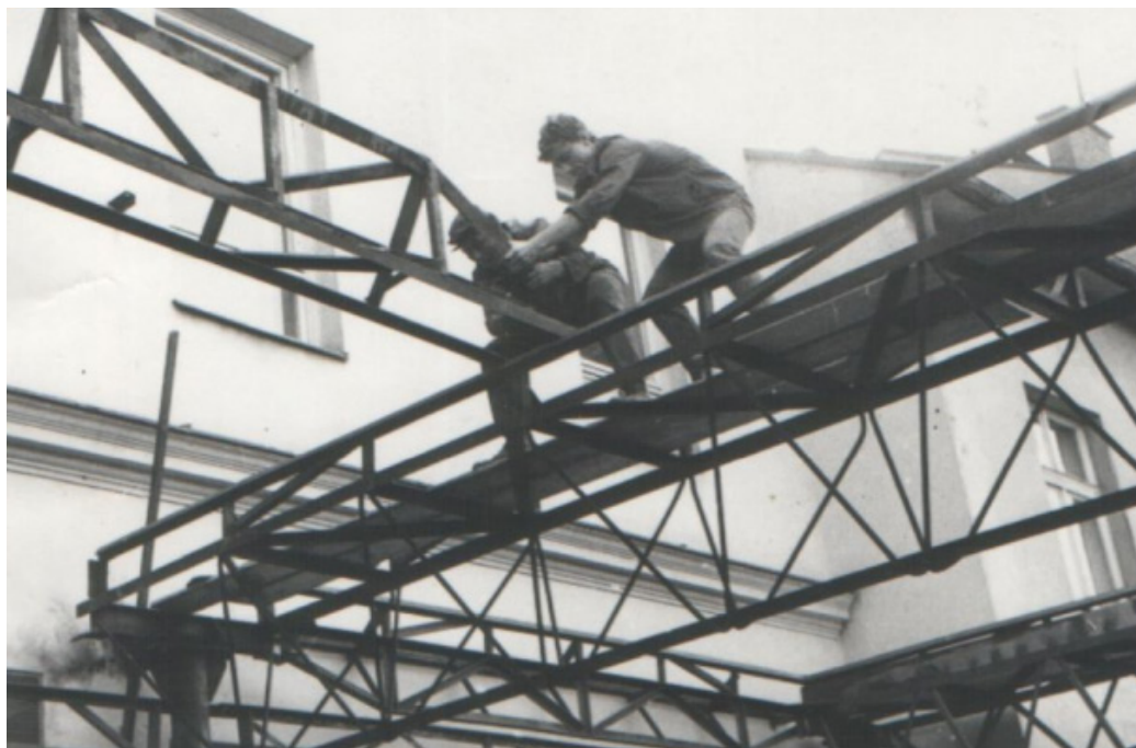
Z prací na přestřešení laboratoří
