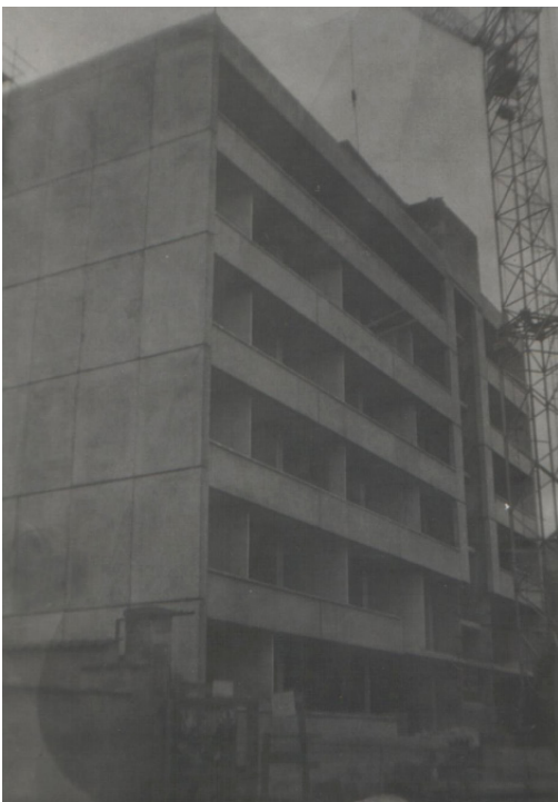
Rozestavěný domov mládeže v Plánkové ulici
